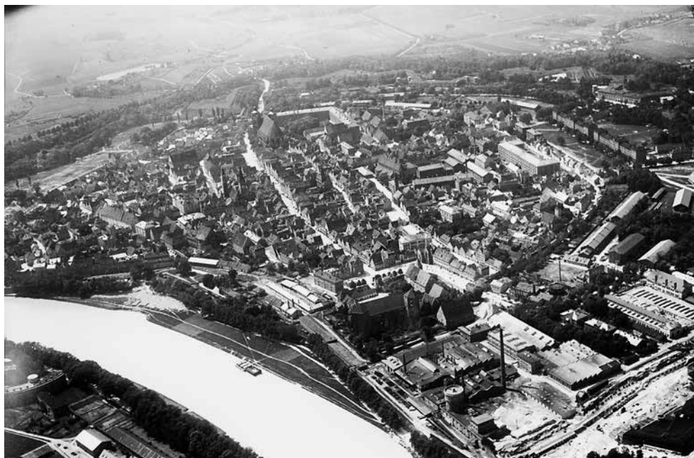
Abb. 3: Ingolstadt 1924, Industrieanlagen im Festungsgürtel im Vordergrund
